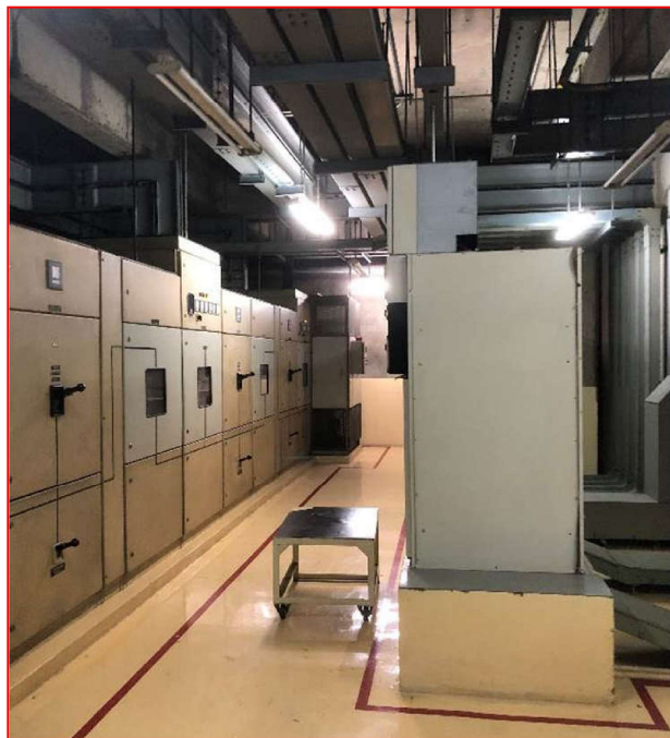
สภาพภายในอาคารชั้นทาวเวอร์ เอ และ บี ห้องระบบ MDB
